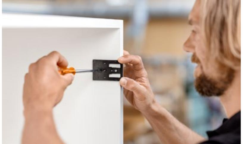
Unsere Verarbeitungshilfen unterstützen Sie beispielsweise dabei, den AVENTOS-Kraftspeicher am Korpus zu positionieren und zu befestigen. Durch die optimale Ausrichtung gewährleisten Sie, dass die Beschläge einwandfrei funktionieren. So wird das Öffnen und Schließen für Ihre Kunden zu einem rundum angenehmen Erlebnis.
