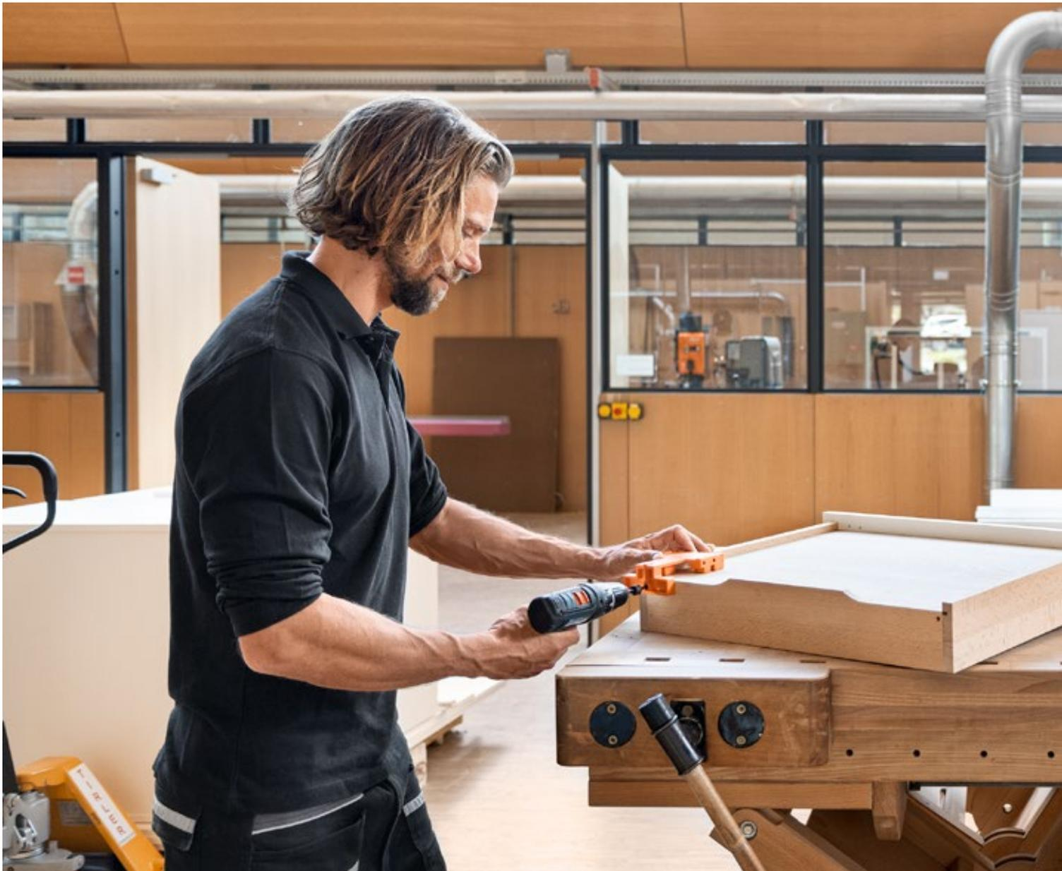
Durch Vorbohren lassen sich Beschläge noch genauer setzen. Dies ist vor allem bei Holz sinnvoll und somit auch bei der Befestigung der Führungsschiene am Schubkasten. Die genaue Bohrposition ermitteln Sie mit unseren Bohrlehren besonders effizient. Und noch einfacher geht es mit MINIPRESS top. Sitten Ihre Schubkästen korrekt auf der Führungsschiene, gewährleisten Sie einen schwebebelegten Lauf.
