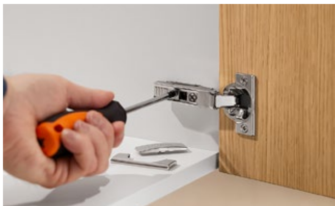
Ajuste tridimensional del frente, ajuste de profundidad continuo con espiral
