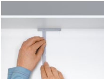
2. С помощью монтажного шаблона выберите место крепления
