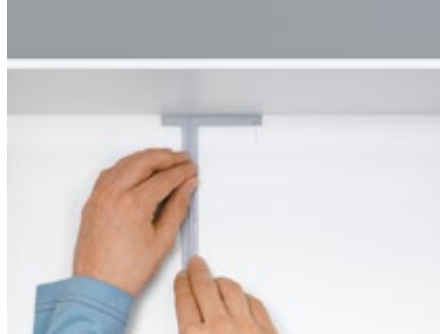
2. Montagehilfe positionieren
