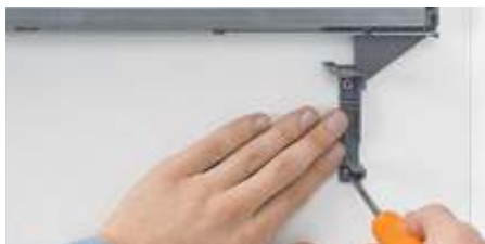
2. Установите держатель несущего профиля и закрепите его
