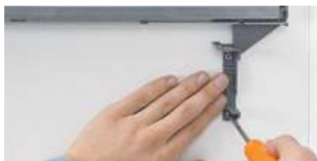
2. Uchwyty profilu nośnego przykręcić w odpowiednim miejscu
