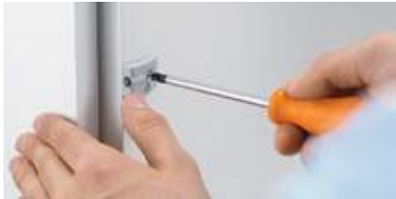
1. Blum-Distanzpuffer montieren
